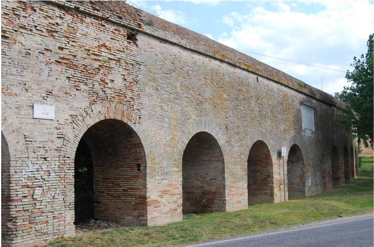
*Foto della condotta ad archi visitabile dell'acquedotto. L'opera risulta in stato di degrado nonostante sia stato presentato un progetto di restauro e risanamento conservativo redatto dall'Ing. Nazareno Battistelli.*
