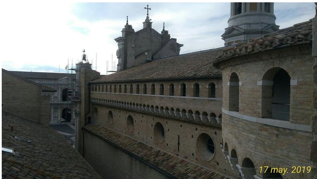
Loreto, Camminamenti di ronda della Pontificia Basilica di Loreto, vista dal basso
